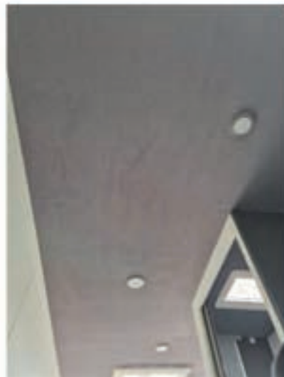
Deckenbeleuchtung via Schalter über dem Kühlschrank
